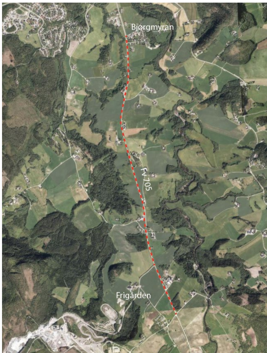
Figur 1 Ny gang- og sykkelveg på strekningen Bjørgmyran-Frigården, Stjørdal kommune
