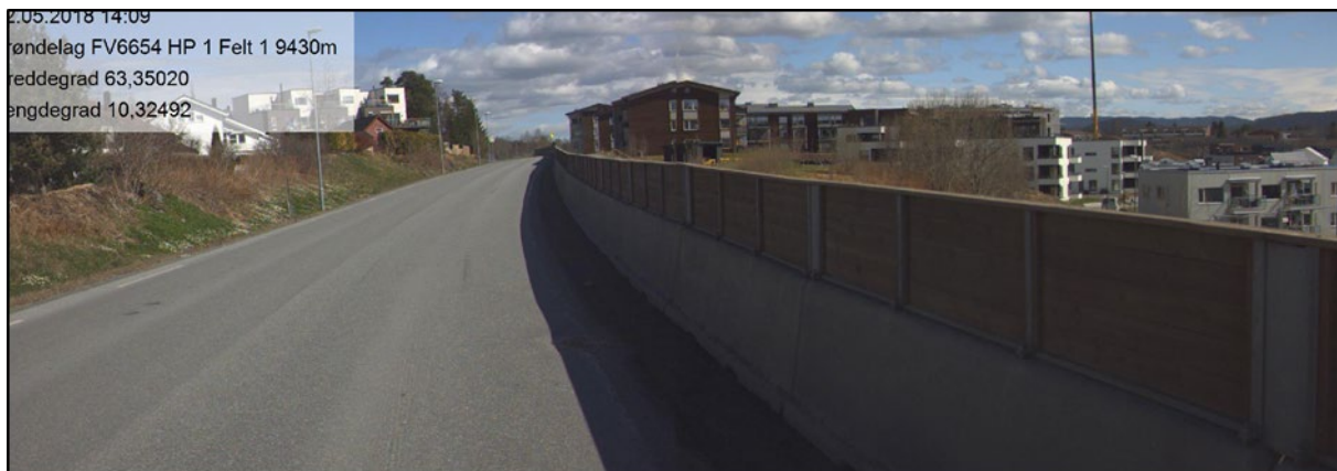
Figur 9: Vegbilde, fylkesvegen avgrenses med støyskjerm på sørsiden og støyvoll på nordsiden.
