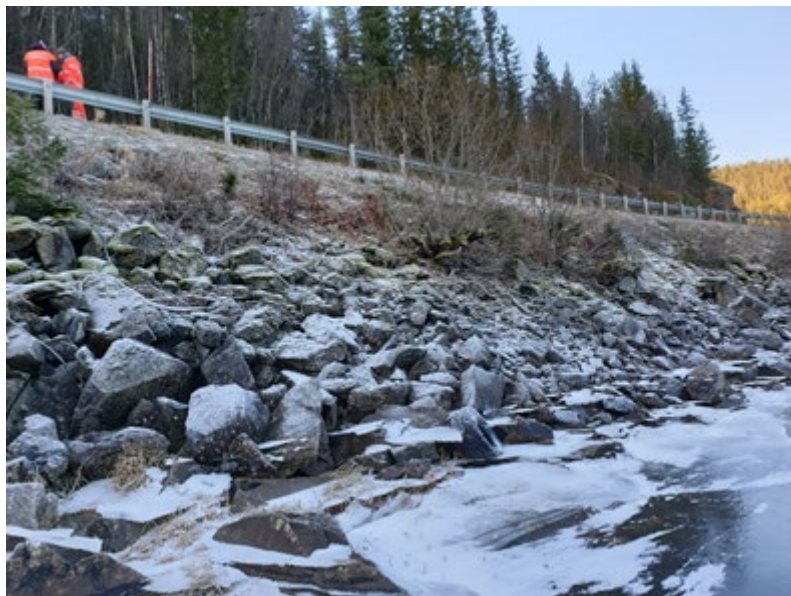
Figur 12: Grov sprengsteins fylling i strandsonen ved Krinsvatnet.
