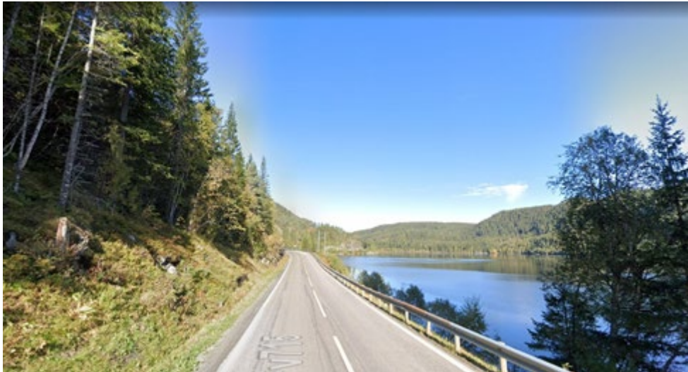
Figur 10: Fv715 sett fra sør mot nord. Krinsvatnet i øst.
