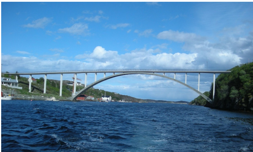
Figur 1: Knarrlagsundbrua Foto: Jan-Tore Egge
