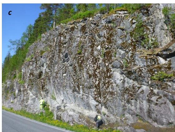
Foto 10 a, b, c: Bergskjæring 11
