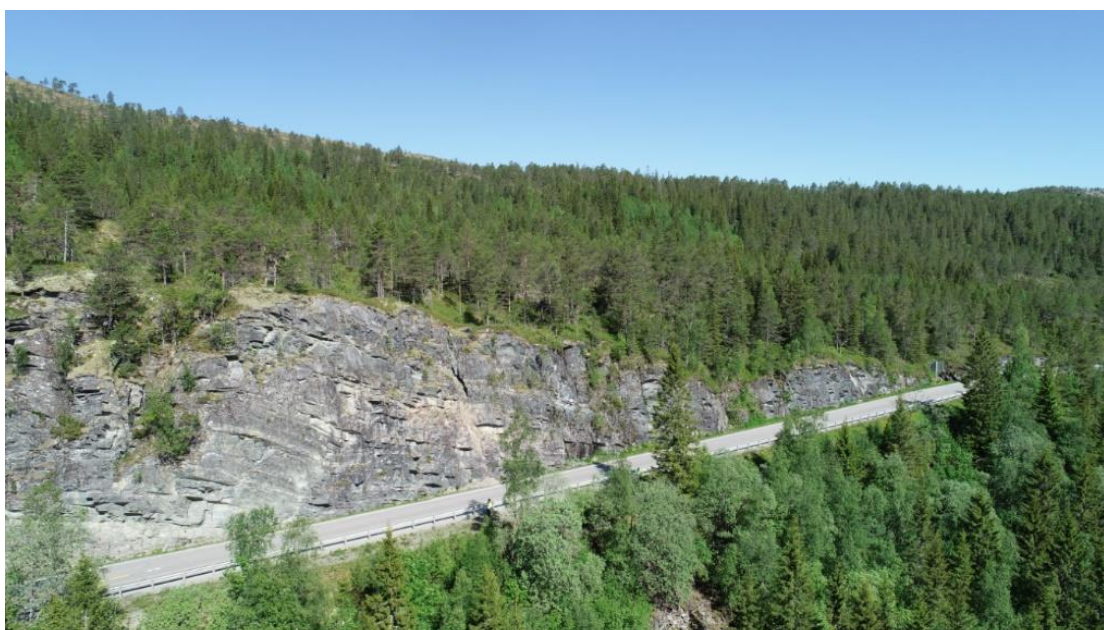
Foto 2: Bergskjæring 1, nordvestre del
