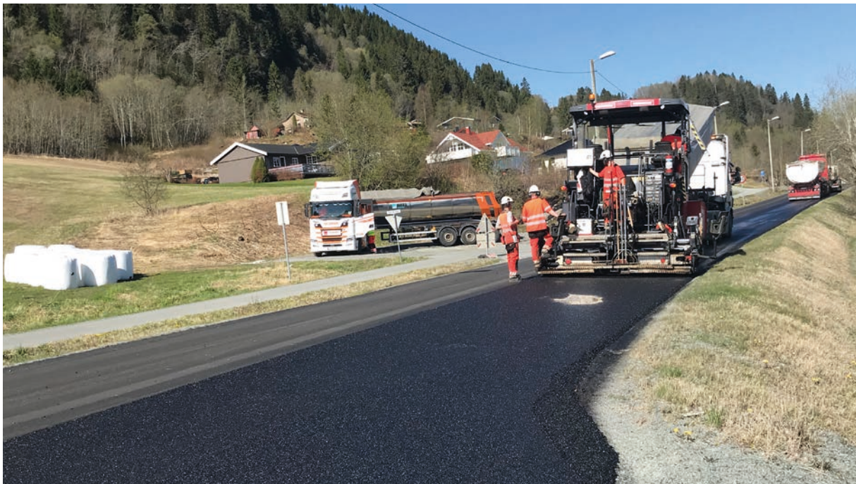
Fv. 800 i Buvika, asfaltering.
