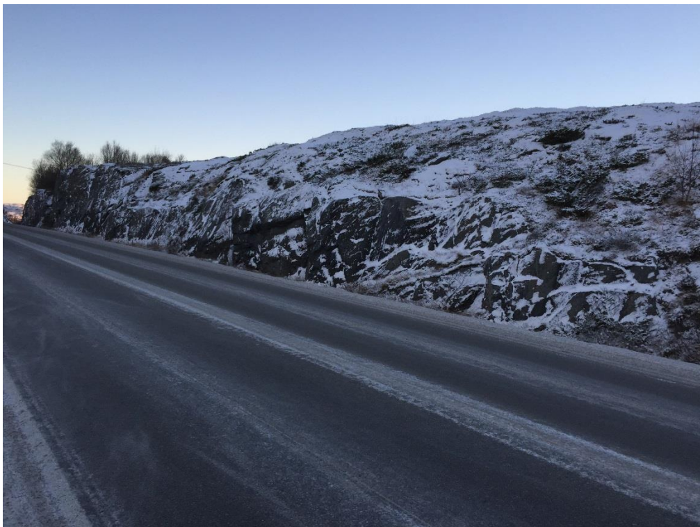
Figur 5. Lav fjellknaus med bergskjæring på nordlige siden fylkesveien. Bilde mot vest.
