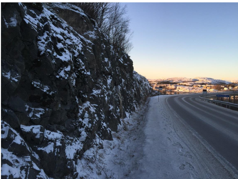
Figur 4. Skjæring på sørlig side av fylkesveien, like ved Nærøysundsbrua. Bilde mot vest.
