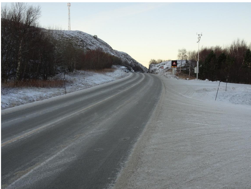
Figur 2. Krysset Fv 770 - kommunevei 322, bilde mot vest. Til venstre, på sørlige siden fylkesveien, en skråning med løsmateriale. Omtrent 100 m vest fra kryssingen går skråningen over i en lav skjæring. Enda lenger mot vest, mot Nærøysundsbrua, går skjæringen i berg. På nordlige siden Fv 770 er en omtrent 5 m høy fjellknaus med skjæring mot veien.
