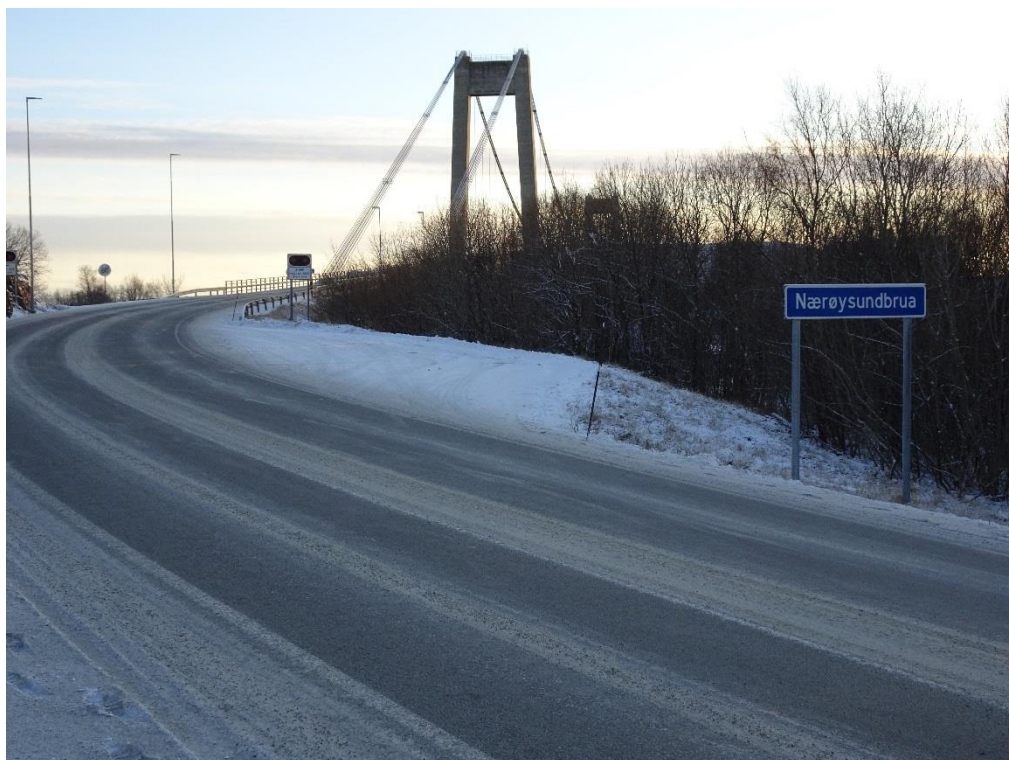
Figur 7. Vestlige brohode, bilde mot øst. Fortau slutter etter broen.
