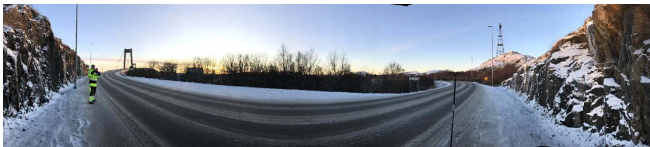
Figur 12. Vestsiden av brua på Vikna siden. Brua har fortau på sørlig side. Bildet tatt mot sørvest. Det finnes mye trær fra brua og sørover.
