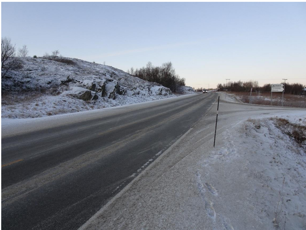
Figur 1. Krysset Fv 770 - kommunevei 209, bilde mot vest. På sørlige siden finnes en ca. 5 m høy skråning med tynt jordlag. Langs Fv 770 er det en 2-3 m høy skjæring. På nordlig side av fylkesveien, til høyre i bilde, er det flatt.
