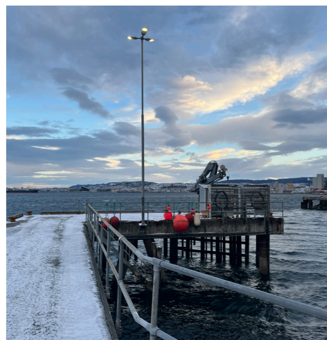
Befaring AURLab, januar 2026 Foto: Rodeo
