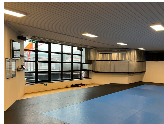
Befaring Trh. Ju jitsu klubb, Fyringsbunkeren, aug. 2025. Foto: Rodeo
