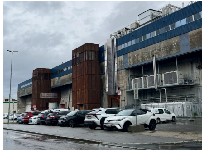
Dora I – fasade mot planområdet med nyere trappetårn og garasjeport for innkjøring
