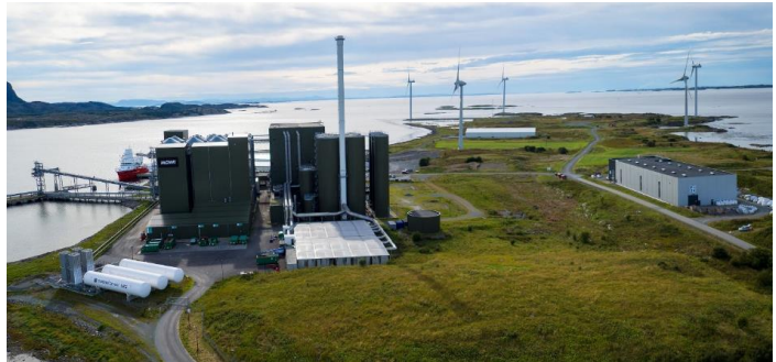
Figur 2-1 Valsneset med Mowi fiskeførfabrikk, kaianlegg, vindmøllepark og lagerbygg. Kilde: Kystens næringsliv.
