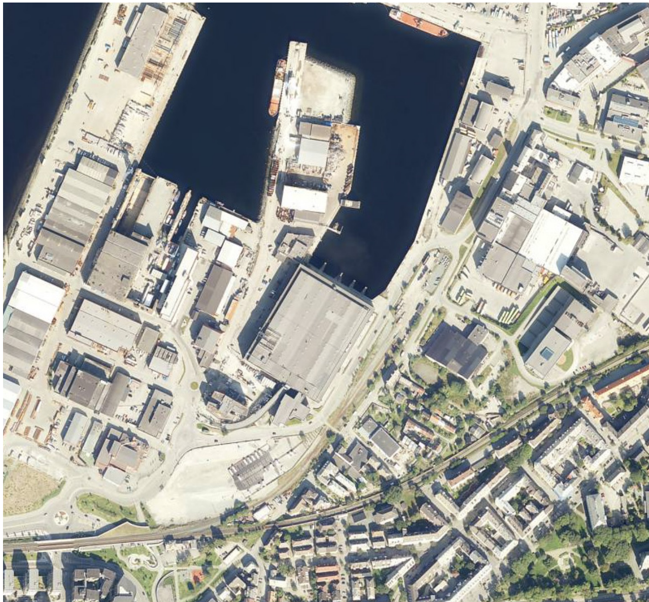
Et område i forandring Maskinistgata 2 ligger på grensen mellom gammel historisk bebyggelse og århundrets transformasjonsprosjekt; Nyhavna.
