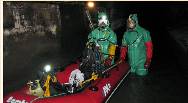
Høvringen kloakktunnel – Adressa 2012
