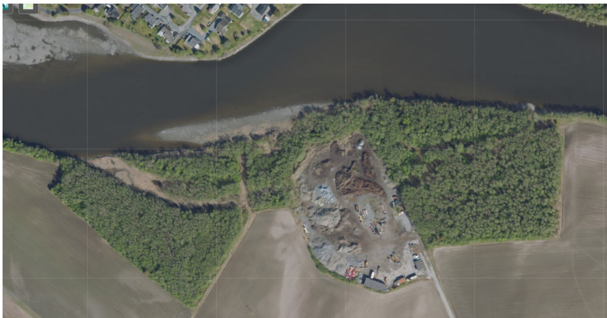
Ved Verdalselva er det f.eks. foretatt inngrep i flomløp og flomskogsmark.
