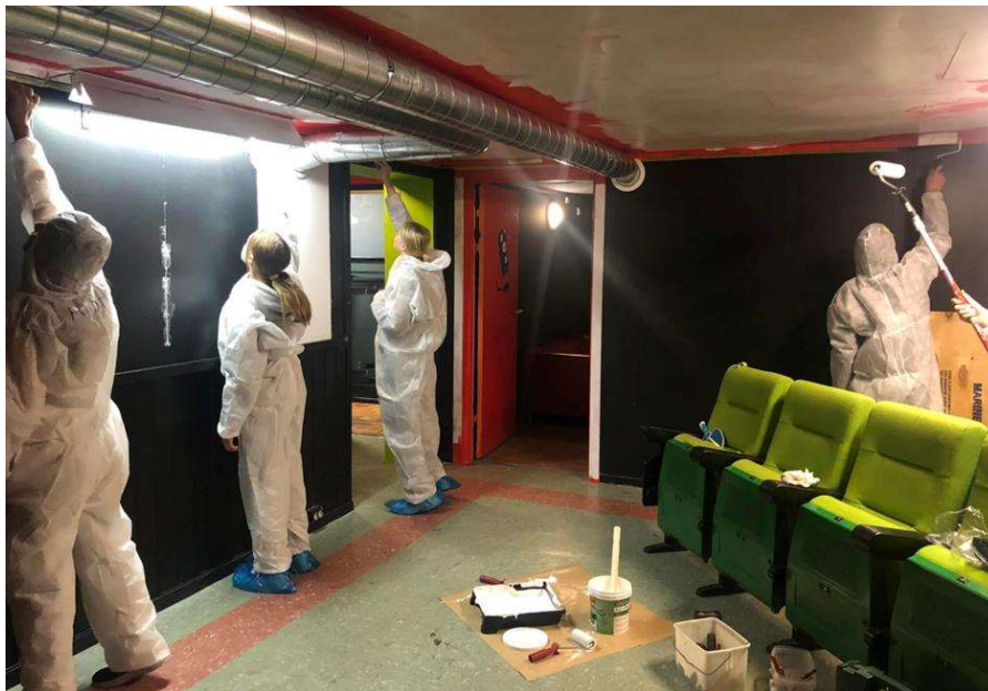
Bilde 6: Oppussing Flatanger fritidsklubb. Kilde: Flatanger kommune
