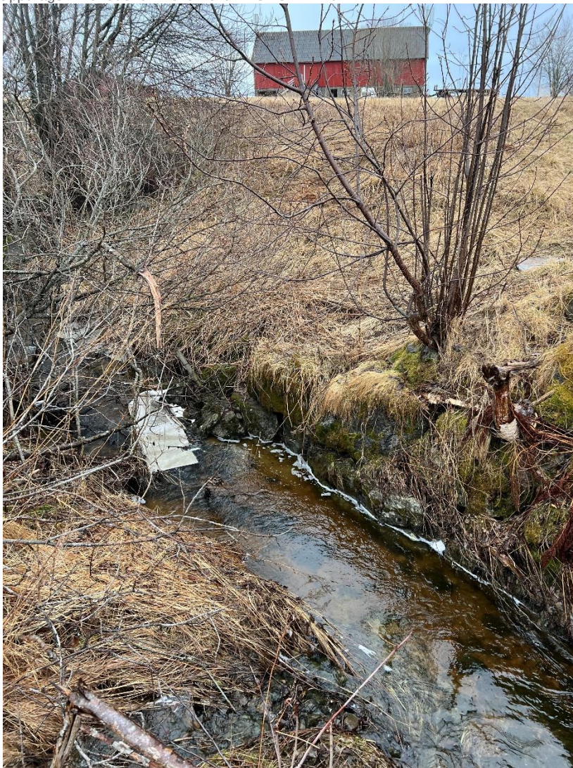
Noe naturlig erosjonssikring langs sidene
