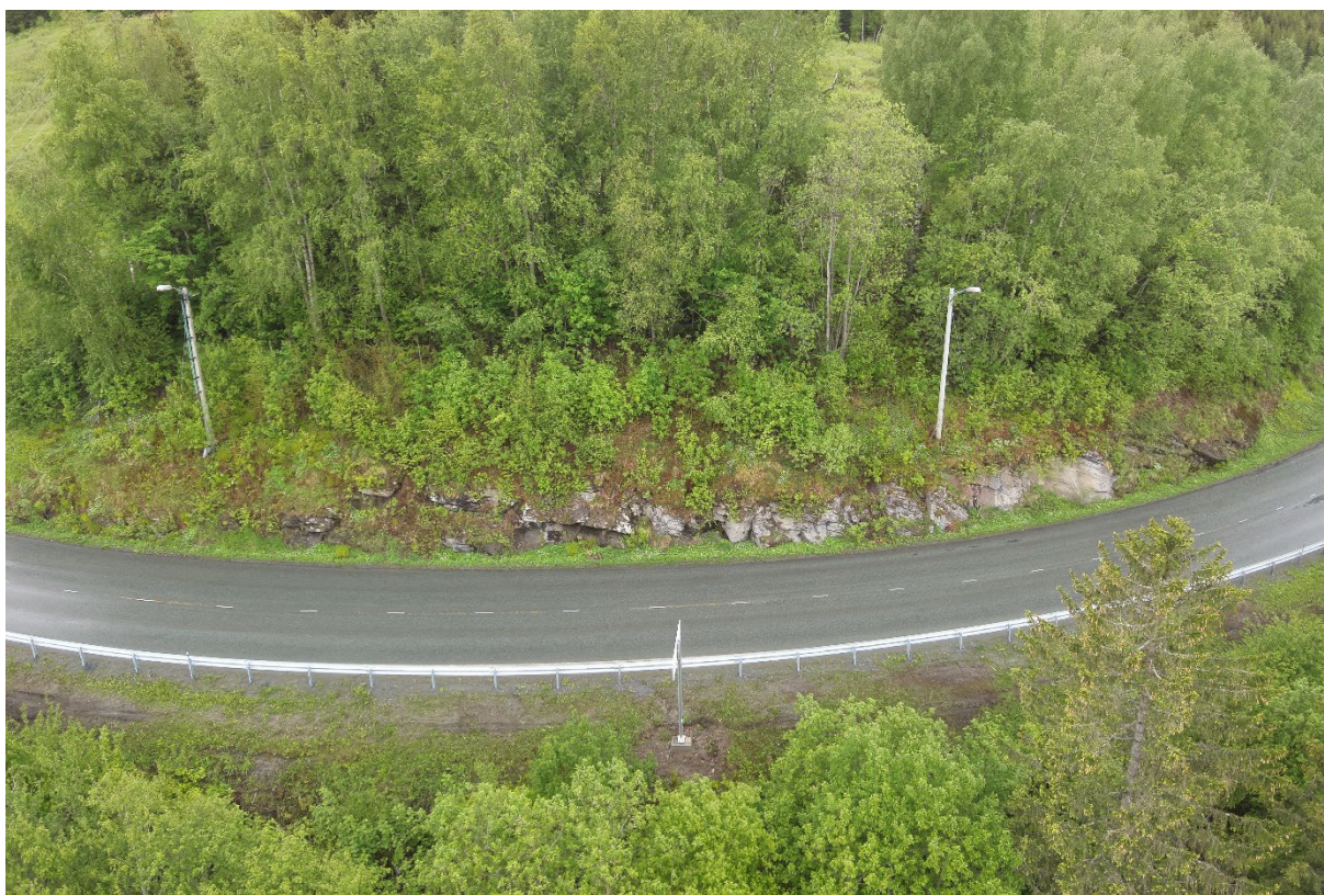
Figur 9: Oversiktsbilde av eksisterende bergsjæring i Grindbergsvingen. Bilde tatt mot sør.
