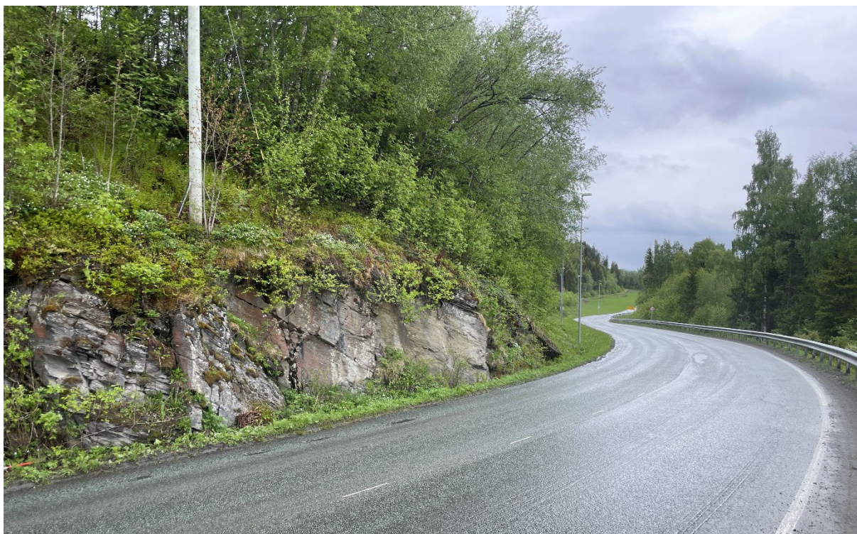
Figur 12: Eksisterende bergskjæring, bilde tatt mot vest.
