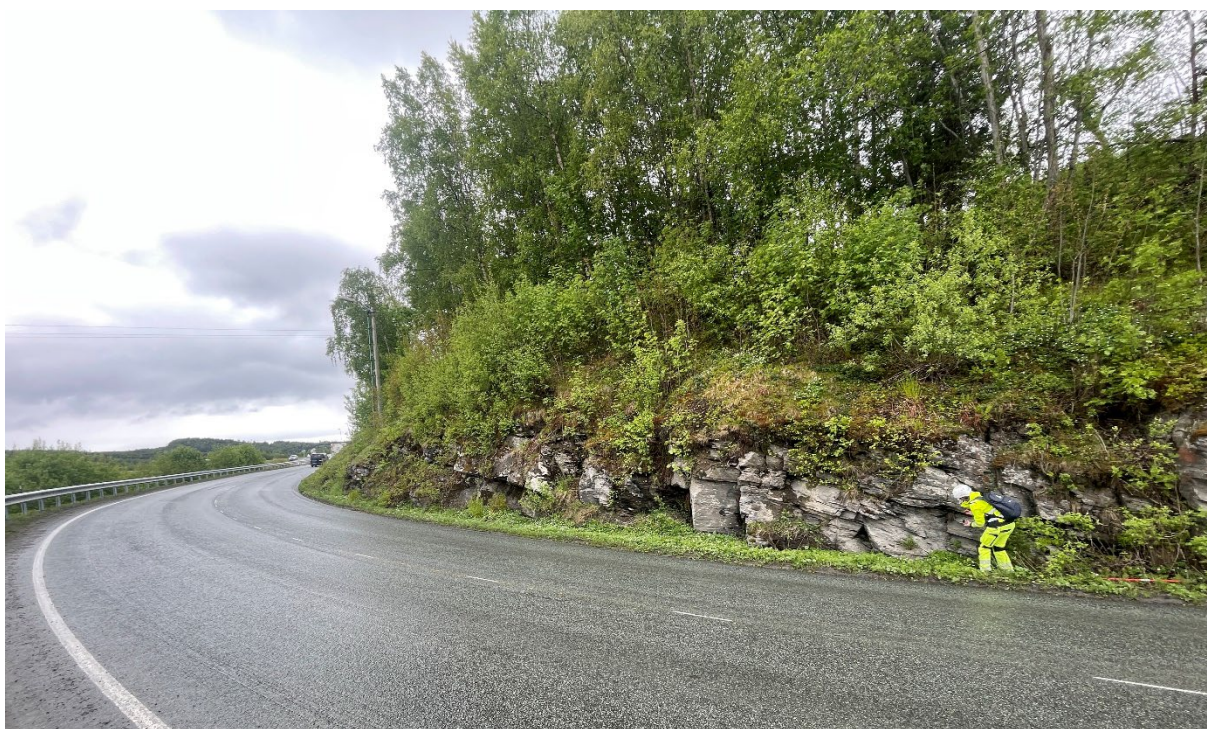
Figur 11: Eksisterende bergskjæring. Bilde tatt mot sørøst.
