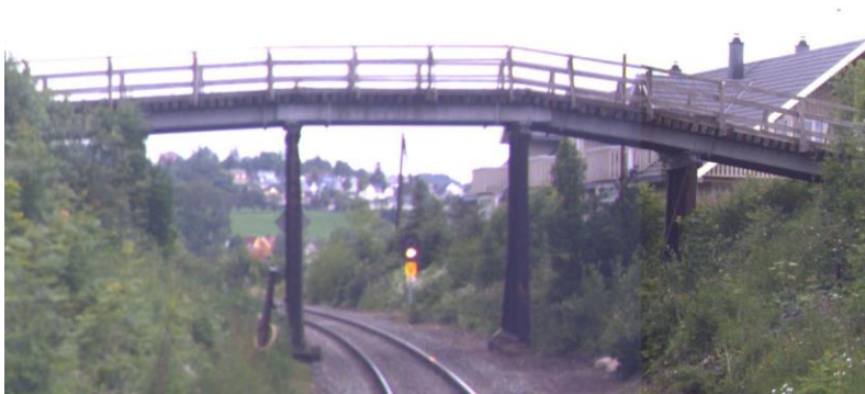
Overgangsbru Være – rives og bygges ny
