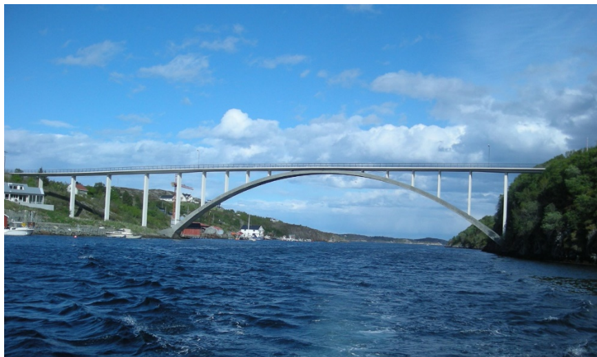
Figur 1: Knarrlagsundbrua Foto: Jan-Tore Egge
