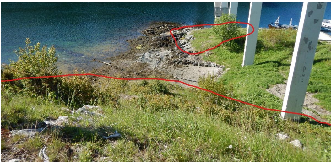
Figur 3-8 Bilde tatt fra grusplass øst for dagens bru, ovenfor de to naturtypelokalitetene med rik berglendt mark (ca. avgrensninger skissert med rødt). Knarrlagsundbrua nord 1 vises bak i bildet. Øvre og vestre del av Knarrlagsundbrua nord 2 vises nærmest i bildet. Foto: Sweco.
