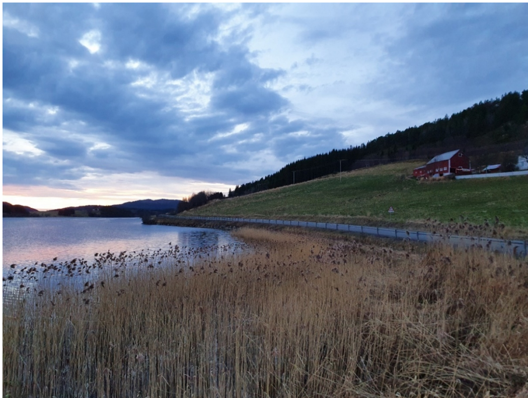
Strekningen Kolvereid – Nakling sett fra planområdet i øst mot vest.
