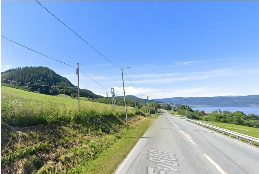
Figur 28: belysning og trafo sør for fv. 800
