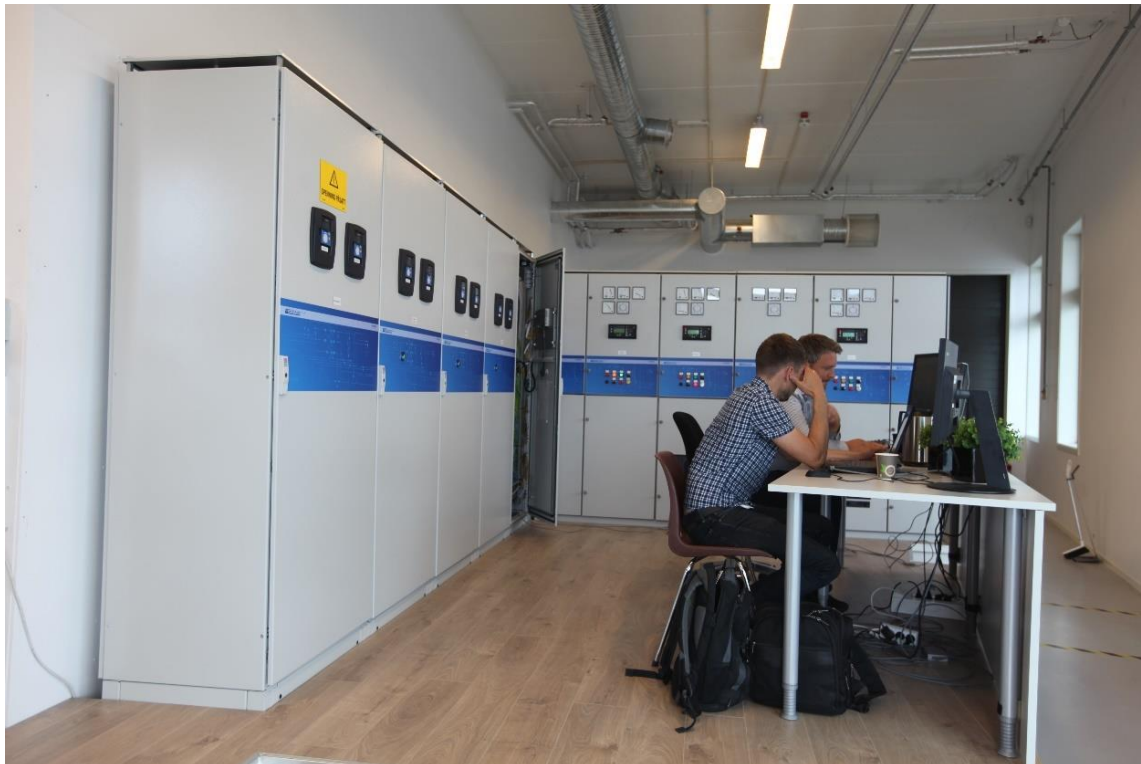
Illustrasjon 34. Westcon Power & Automation har bygd egen testlab for batteri- og hydrogenbaserte energisystem. In-house testing av brenselceller og hydrogenbaserte energisystem gir mulighet til hurtige tester for å finne løsninger på utfordringer som ev. dukker opp under utvikling av fullskala energisystem
