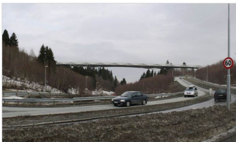
Figur 9 Oversiktsbilde Saupstadbrua, sett fra krysset John Aaes veg - Bjørndalen (kilde: Miljøpakkens prosjektside 4 )
