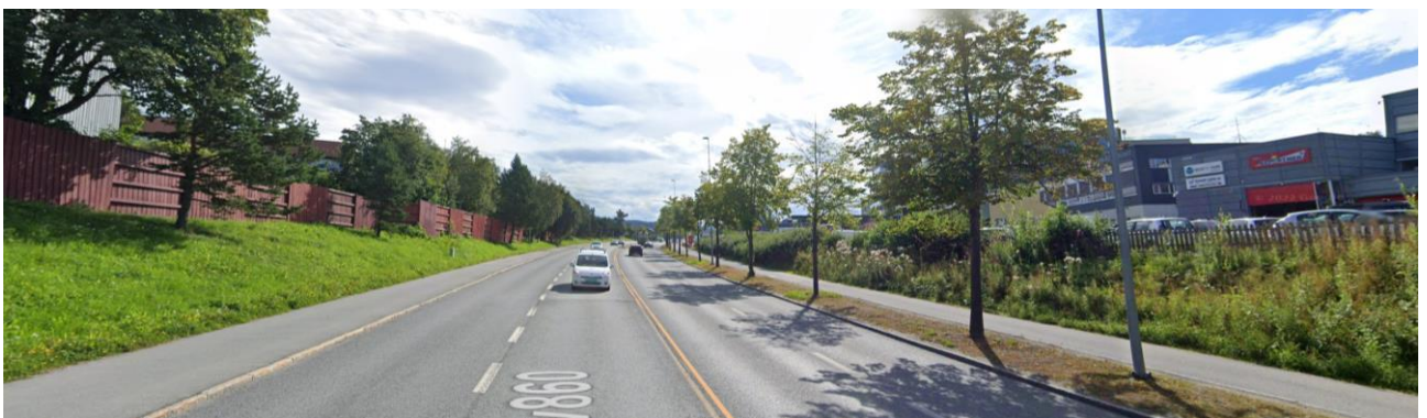
Figur 29 TBV ved Nardovegen 4
