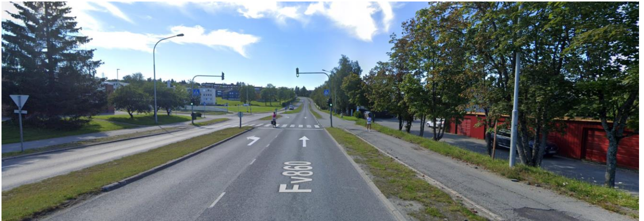
Figur 37 Utleirvegen ved krysset til Steindalsvegen
