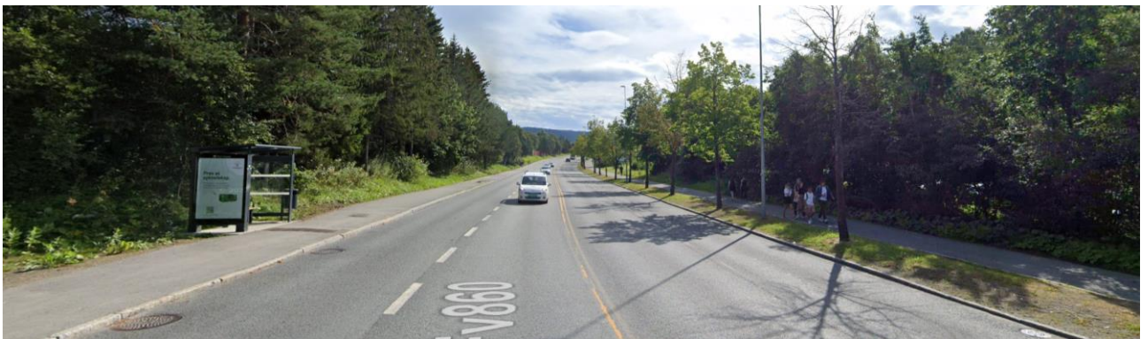
Figur 28 TBV ved bussholdeplassen Dybdahls veg
