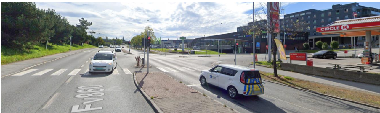
Figur 30 TBV ved krysset til Nardobakken
