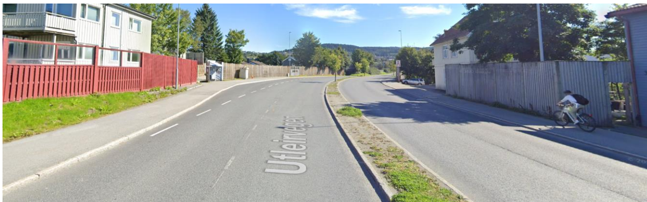
Figur 24 Vegsituasjonen i Utleirvegen bærer preg av at privatbil er prioritert. Flere boliger vender ut mot gateløpet og støyskjermer ligger inntil vegkanten flere steder. Ny vegløsning vil fremdeles gi store trafikkarealer, men eget fortau har stor betydning for bo- og nærmiljøet.
