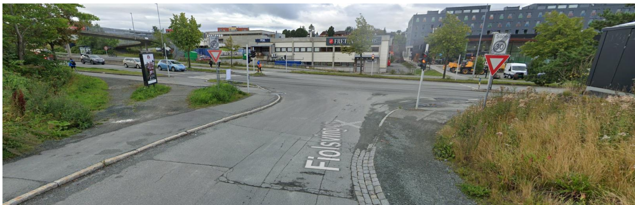
Figur 9 Krysset Fiolsvingen - Torbjørn Bratts veg inngår i planavgrensningen, men det er i utgangspunktet ikke planlagt ny vegløsning i krysset. Fiolsvingen er adkomst til barnehage, idrettsanlegg og friområde ved Nissekollen og gang- og sykkelvei med forbindelse til Moholt. Miljøpakken planlegger snarveiprosjekt i Nissekollen- området.
