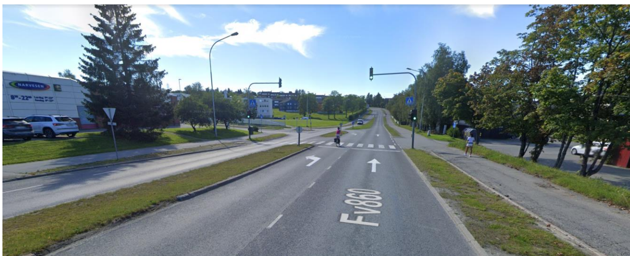
Figur 27 Planområdet slutter i krysset Steindalsvegen - Utleirvegen. Dette er en viktig adkomstveg til Steindal og Hoeggen skoler. Det pågår parallelt planarbeid fra dette krysset og til krysset Blaklivegen - Utleirvegen ved Risvollan i regi av Trøndelag fylkeskommune.
