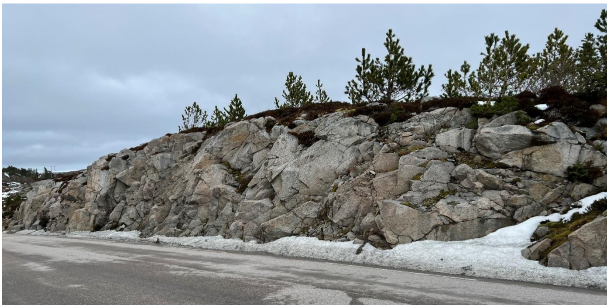
Figur 23: Østlig skjæring, Kvernøya, ca. 5 m høy.
