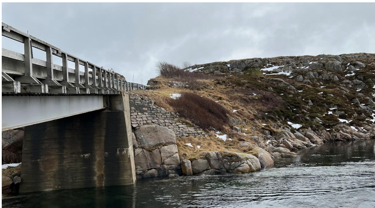
Figur 9: Oversiktsbilde av fundamentområde Kvernøystømmen sør. Bilde er tatt mot sørøst.
