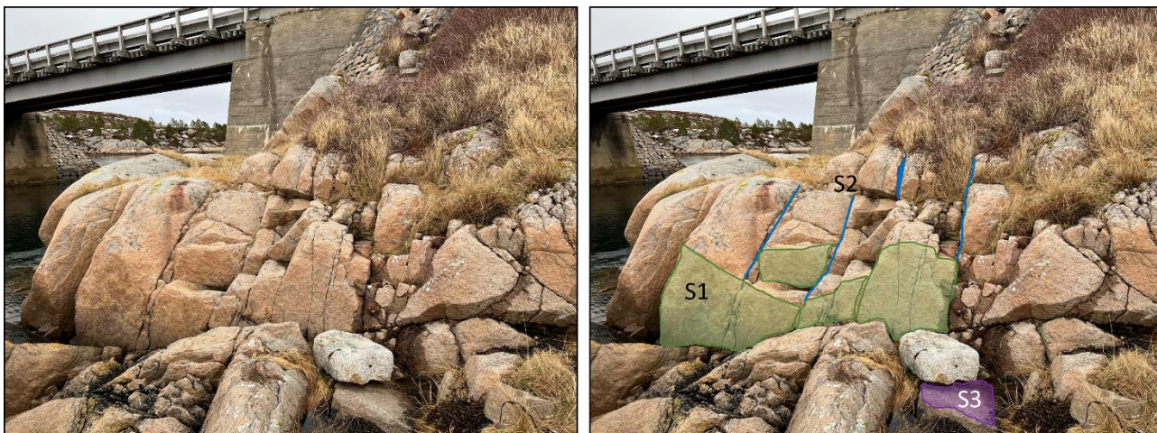
Figur 20: Sprekkesett S1, S2 og S3 ved fundamentområdet. Uten hjelpelinjer (venstre), med hjelpelinjer (høyre).
