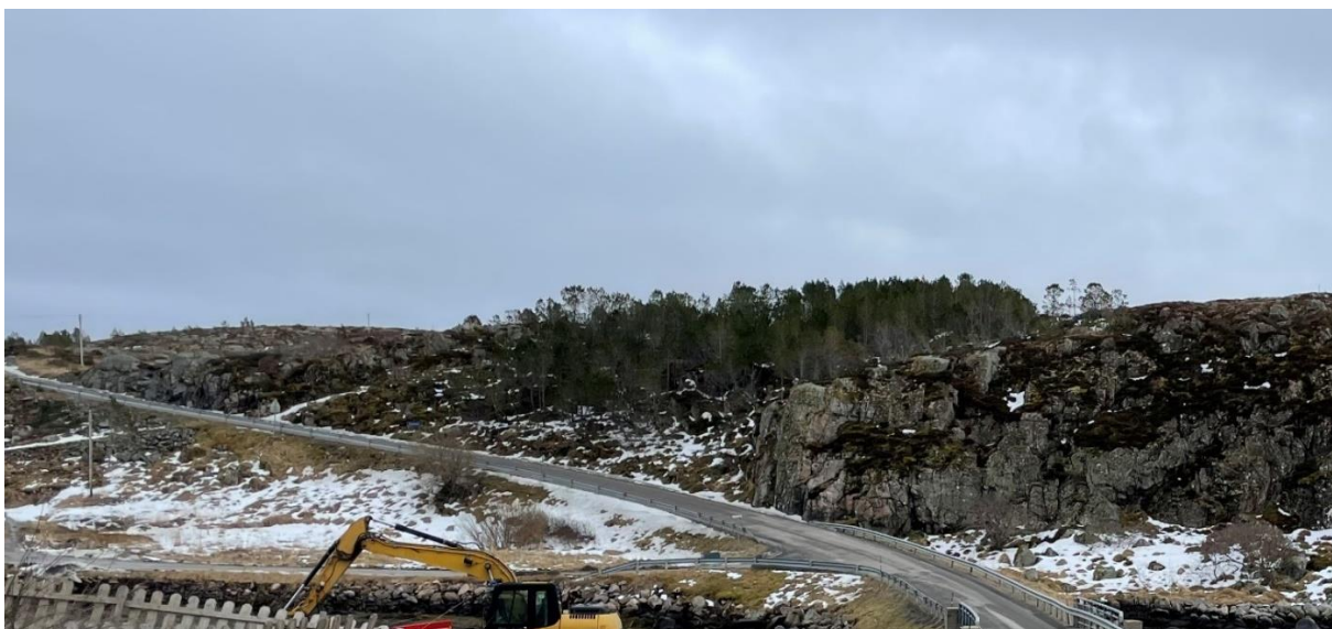
Figur 12: Oversiktsbilde øst for Trøastrømmen. Ny veglinje vil gå inn i bergknausen og gi opptil 12 meter høy bergskjæring. Skjæringen vil fortsette parallelt med dagens veglinje gjennom skråningen med furuskog. Bilde tatt mot øst.
