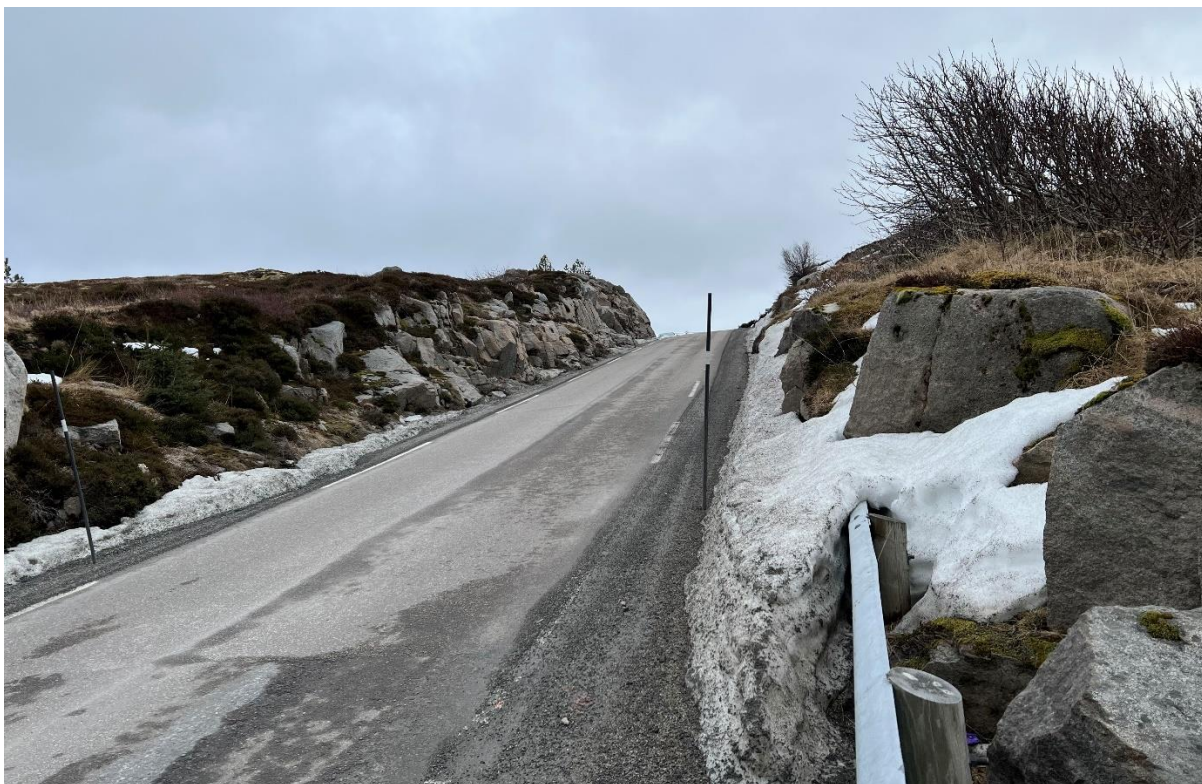
Figur 11: Eksisterende veg over Kvernøya. Bildet er tatt i retning sørøst.
