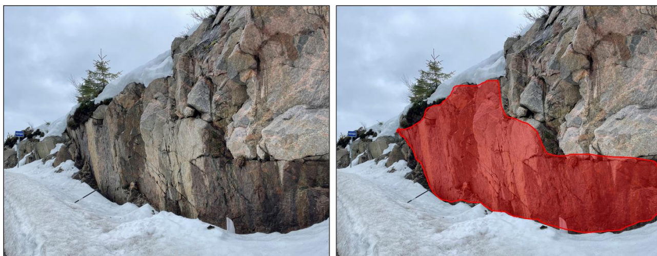
Figur 18: Mulig forkastning observert langs vestlig skjæring mellom Kvernøystømmen og Trøastrømmen. Forkastningen er subparallel med ny veglinje. Uten hjelpelinjer (venstre), med hjelpelinjer (høyre).
