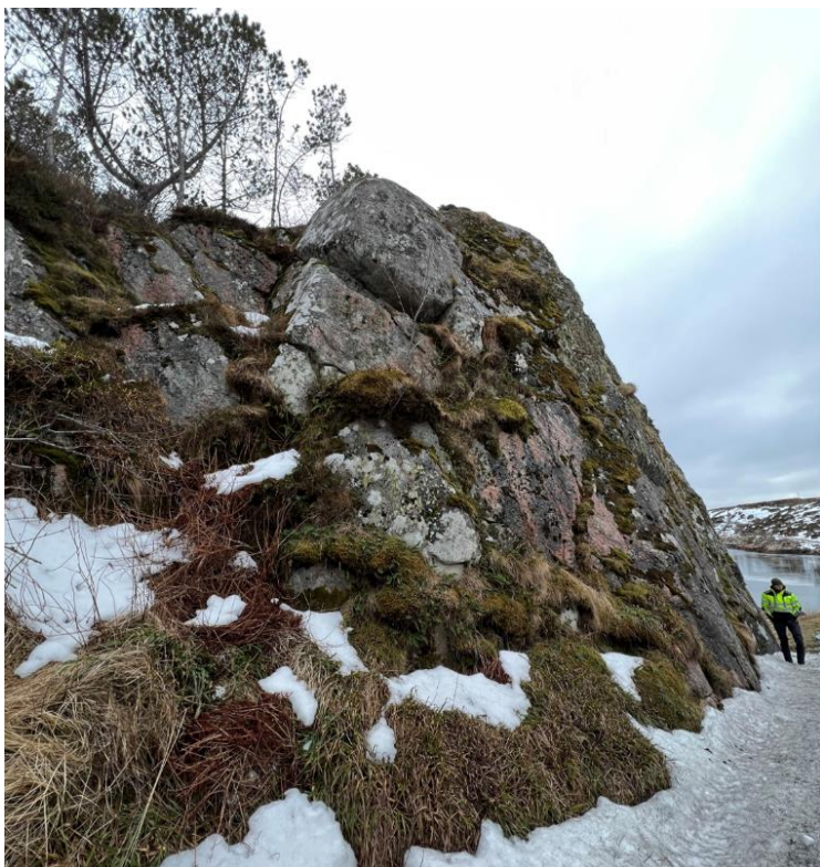
Figur 28: Blokk på topp av bergskjæring som virker delvis avløst av sprekkesettene i området.
