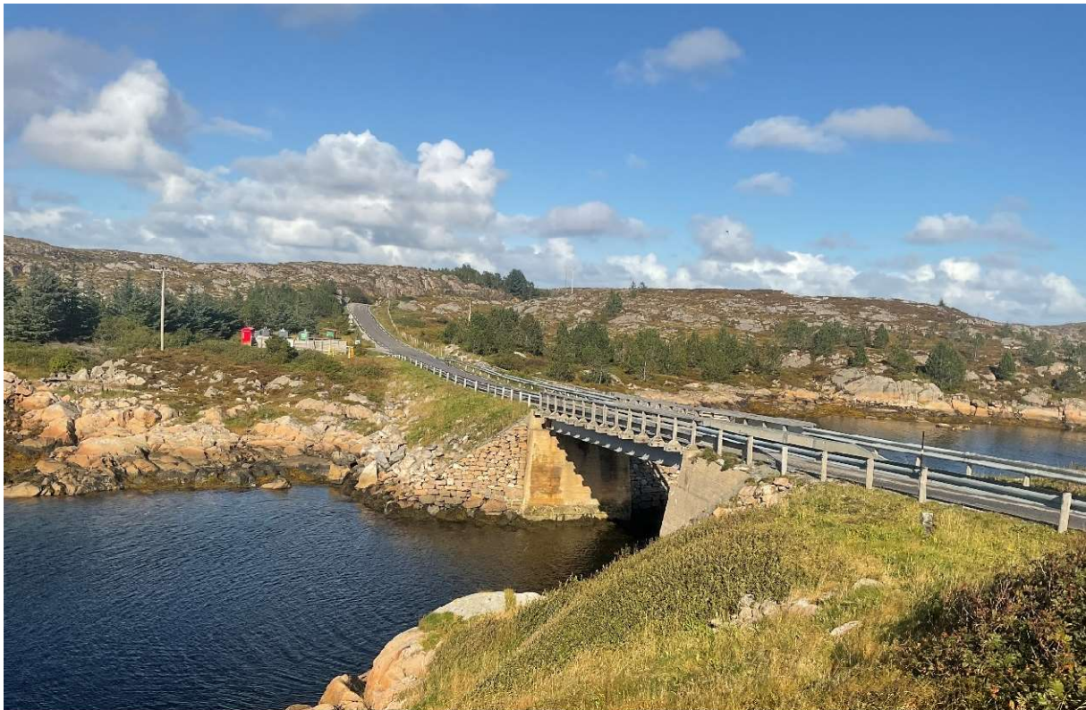
Figur 2-2: Området rundt Kvernøystrømmen. Sett mot nordvest (foto: Norconsult, september 2022).
