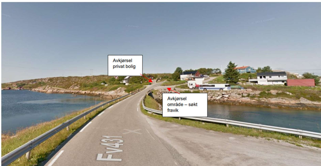
Figur 3-4: Avkjørsel som må flyttes (privat bolig, Dyrøveien 599) og avkjørsel hvor det er søkt fravik (google streetview, bearbeidet av Norconsult).
