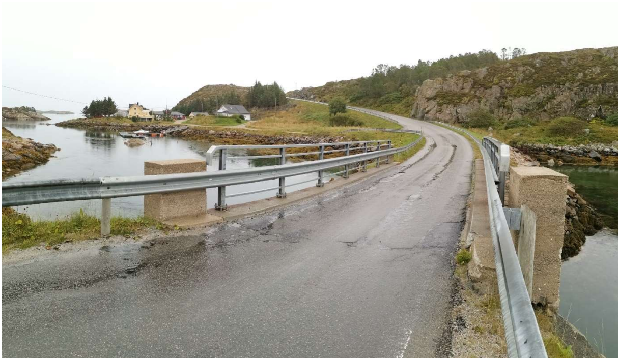
Figur 2-16: Trøastrømmen bru, sett mot nordøst (foto: Norconsult, september 2022).
