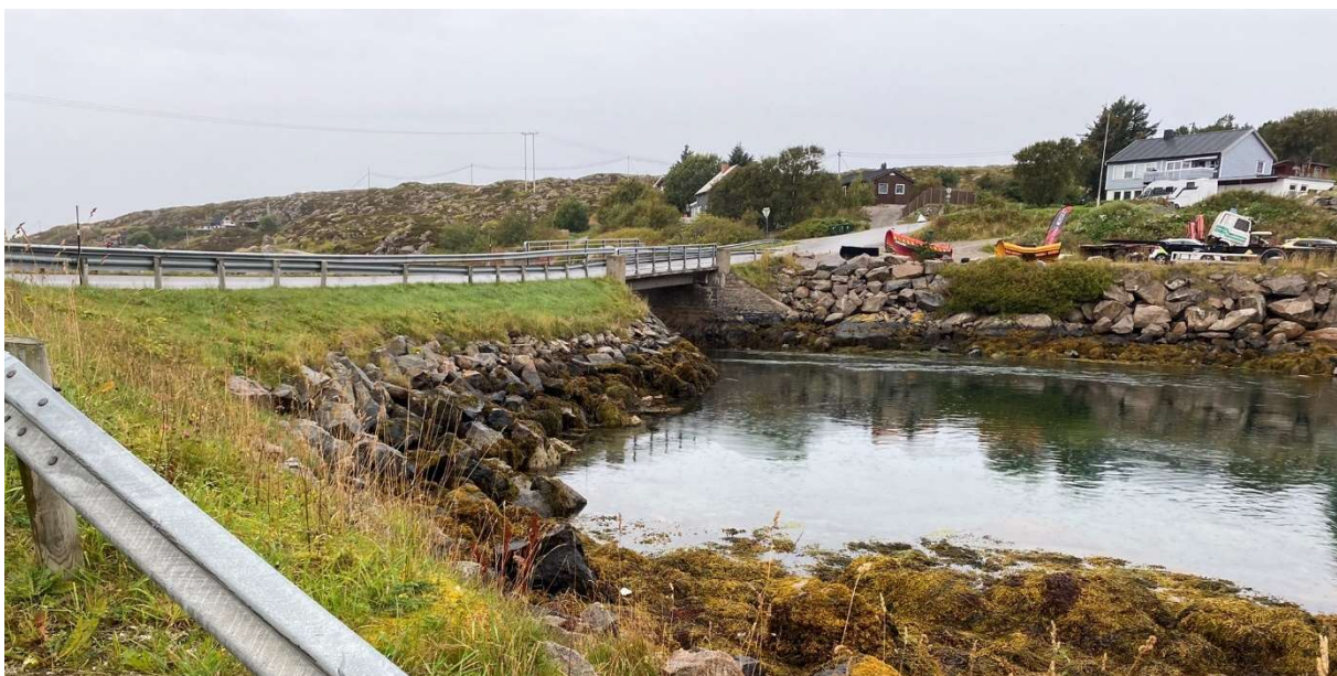
Figur 2-14: Bru over Trøststrømmen, sett mot sørvest (Foto: Norconsult, september 2022).
