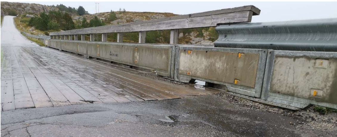
Figur 2-18: Tredekke på Kvernøystrømmen bru (Foto: Norconsult, september 2022).
