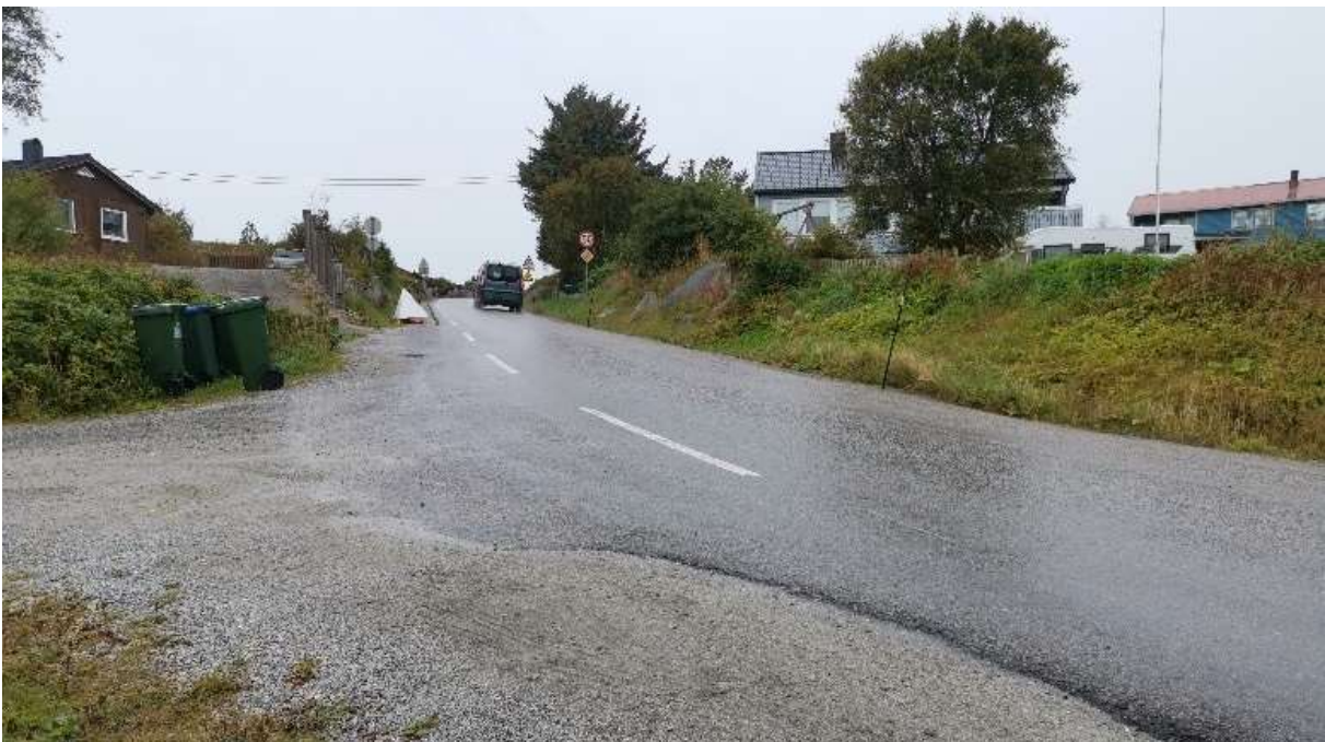
Figur 2-8: Fv. 6466 på Kvernøya sett mot nordvest. Bebyggelse på begge sider av vegen (foto: Norconsult, september 2022).
