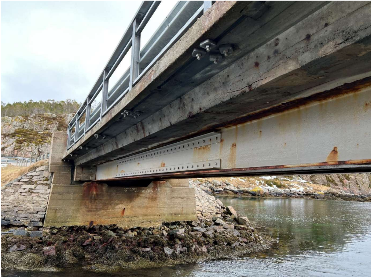
Figur 2-15: Trøastrømmen bru sett fra undersiden (foto: Norconsult, mars 2023).
