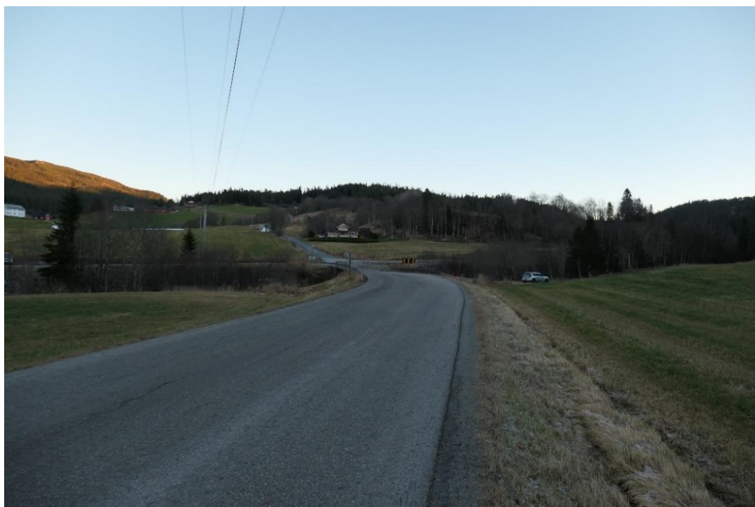
Figur 4-3: Fylkesveg 720 inn mot Alsetbrua i bakgrunnen.
