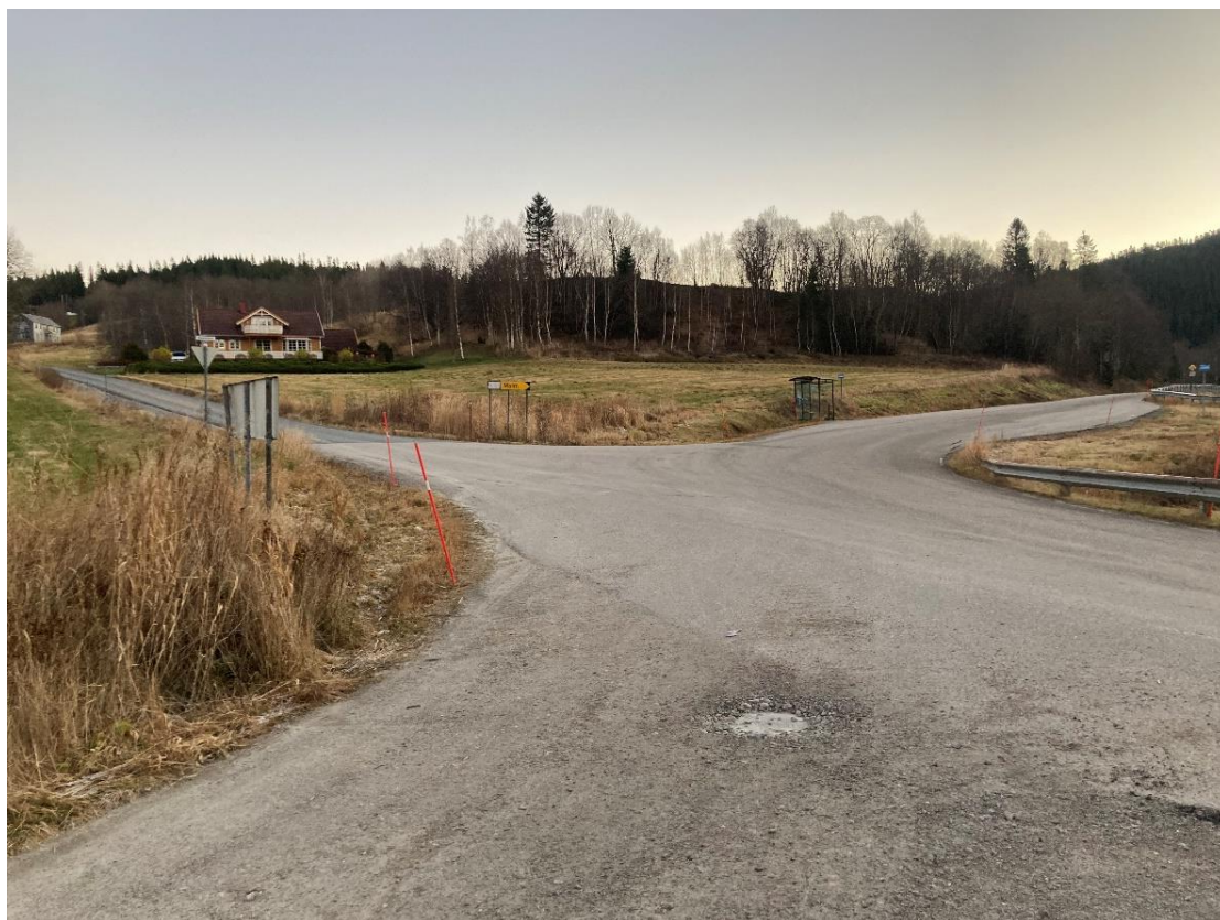
Figur 4-4: Fv. 720 til høyre i bildet. Til venstre avkjørsel mot Alsetveien retning Malm (COWI).
