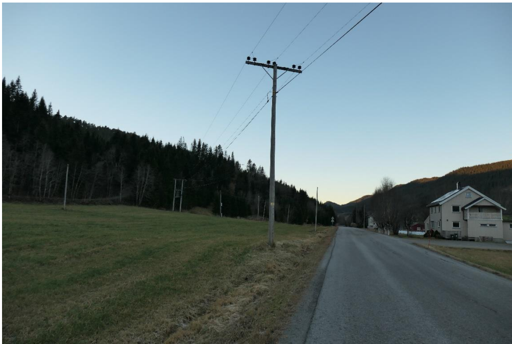
Figur 4-9: Høyspentkabel krysser over fylkesvegen sør for Alsetbrua (COWI).
