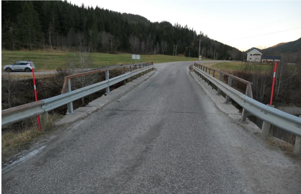
Figur 4-6: Eksisterende bru (COWI).
