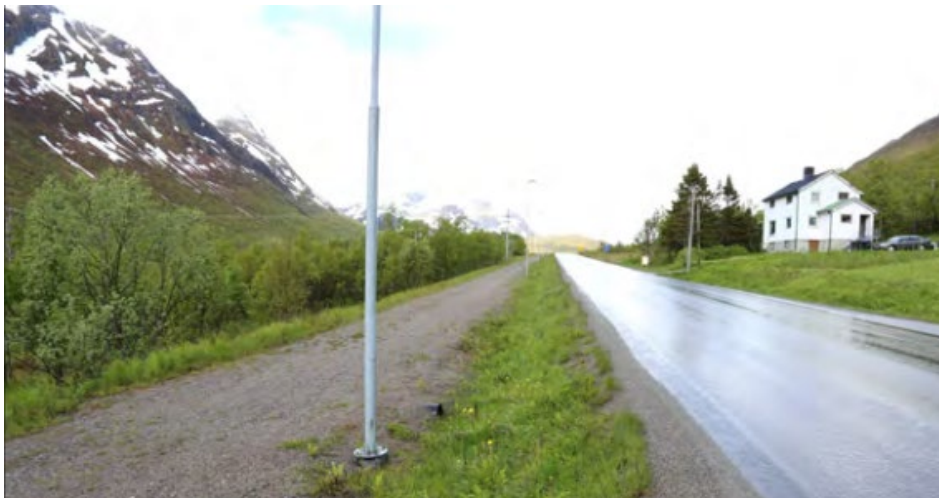
Figur 7: Gang- og sykkelveg med grusdekke (Statens vegvesen). NB: Lysstolpe står i sikkerhetssonen, noe som må unngås.
