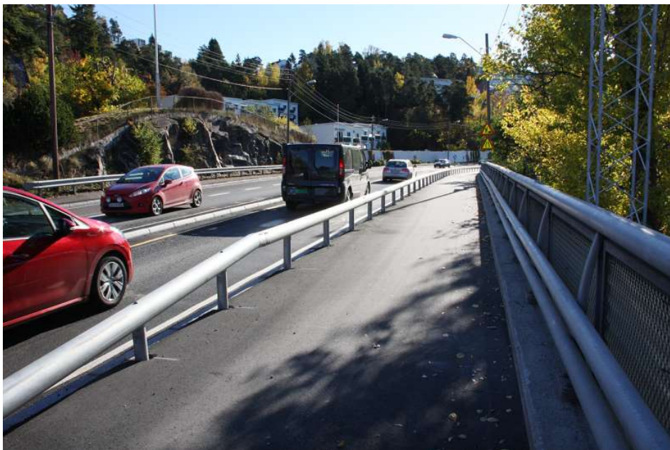
Figur 16: Gang- og sykkelveg med rekkverk (Statens vegvesen)
