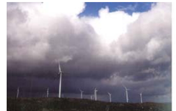
Vindturbiner Hitra (Statkraft)
