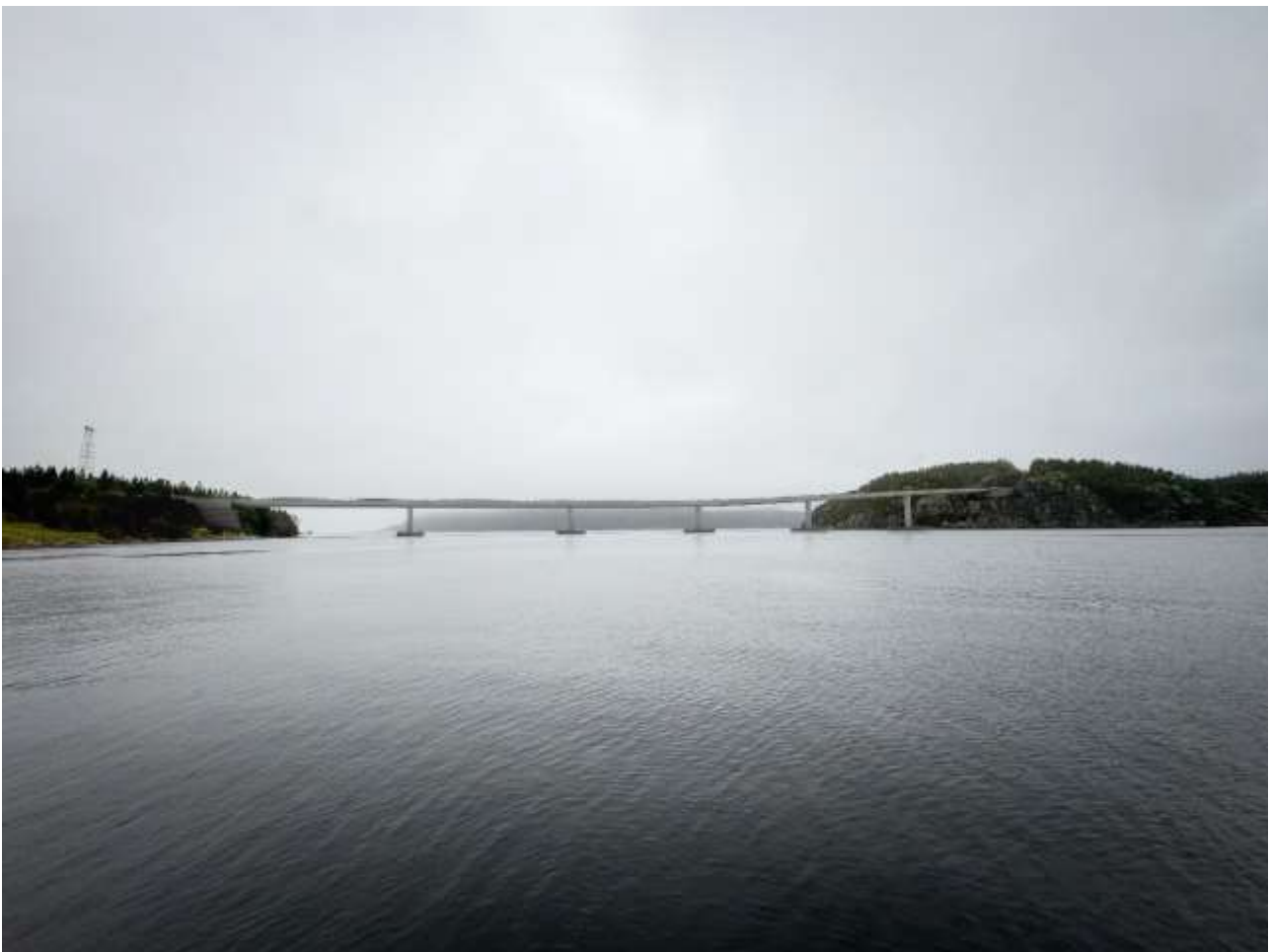
Figur 1-4: Brua sett fra kai på Jøa. Kilde: Norconsult/Nordic Office of Architecture
