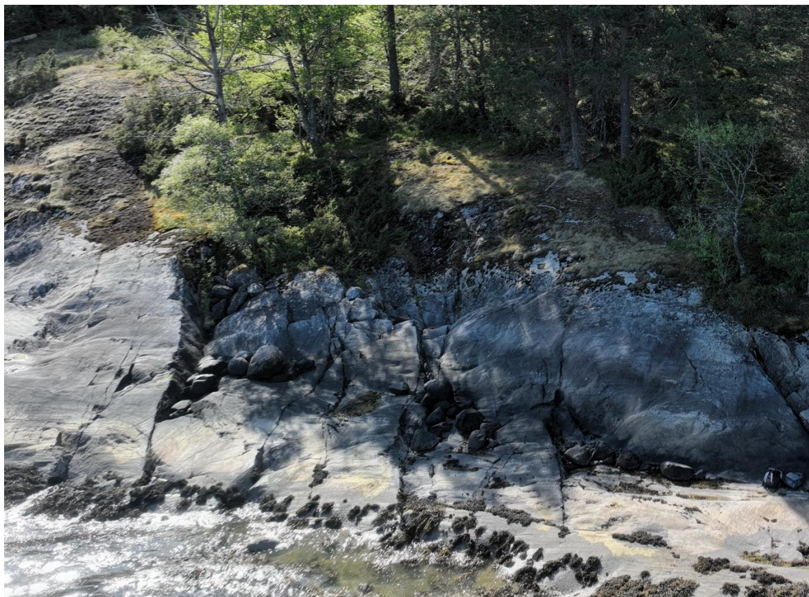
Figur 3-16: S2 framstår som det tydeligste sprekkesettet med utholdende, hakkete sprekker på tvers av foliasjonen, og ses tydelig i svaberget langs sjøen. Bilde tatt mot vest, planlagt landkarplassering er i skogkanten øverst i bildet.
