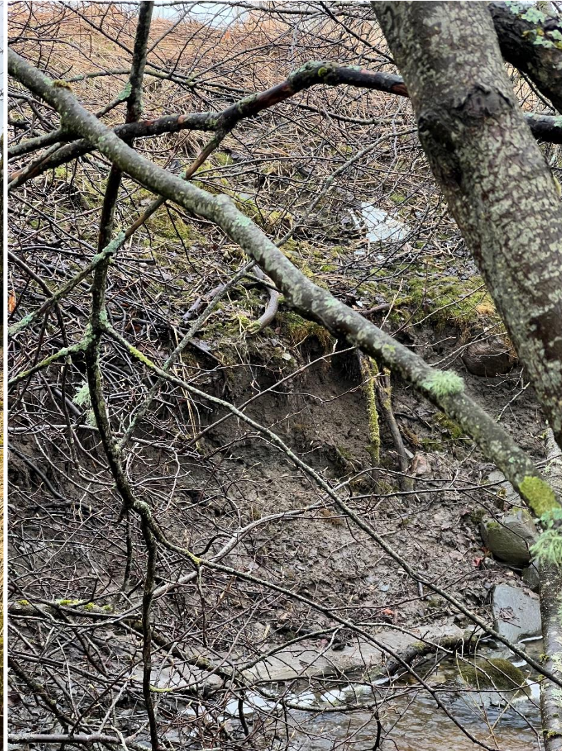
Erosjon av lett eroderbare masser
