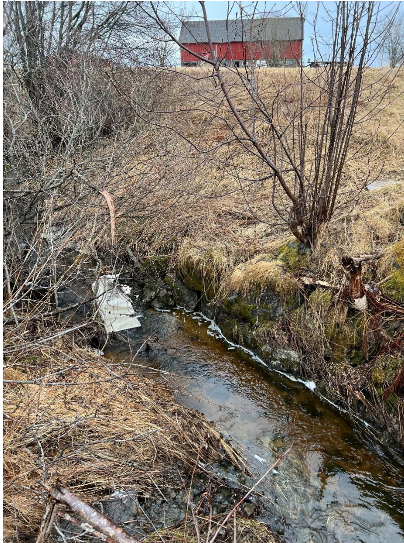
Noe naturlig erosjonssikring langs sidene
