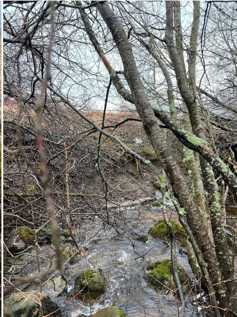
Noe naturlig erosjonssikring langs bunn
