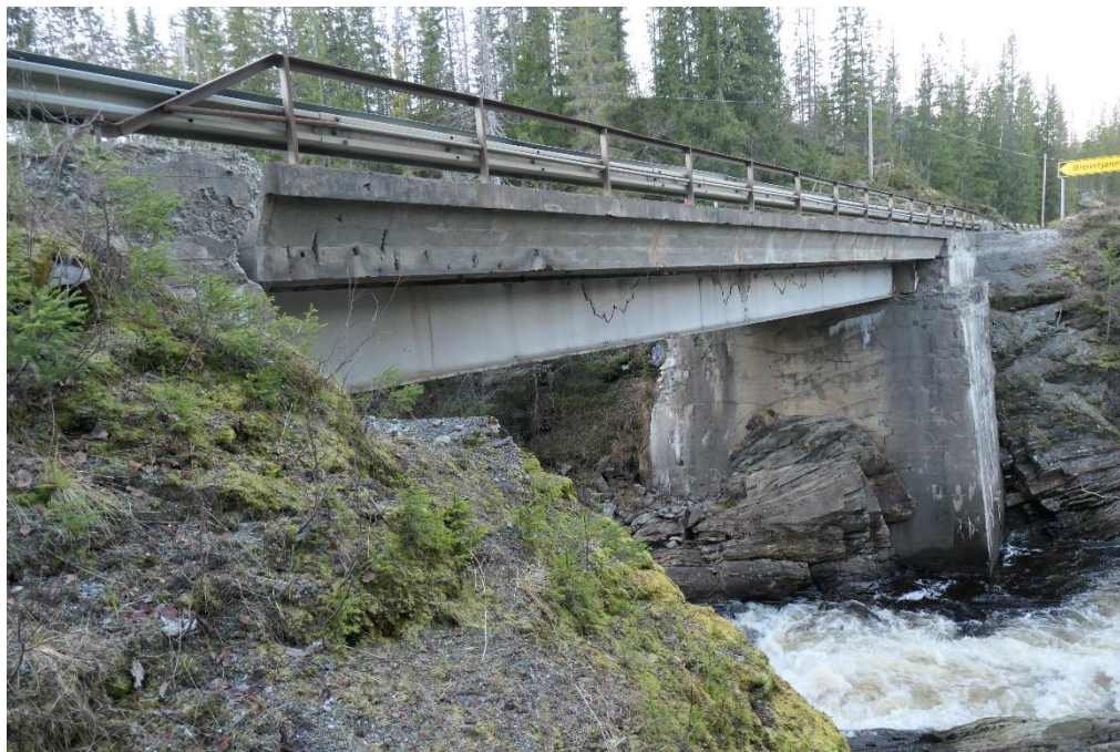
Figur 1-1: Bilde av eksisterende Kvernbrua (COWI).
