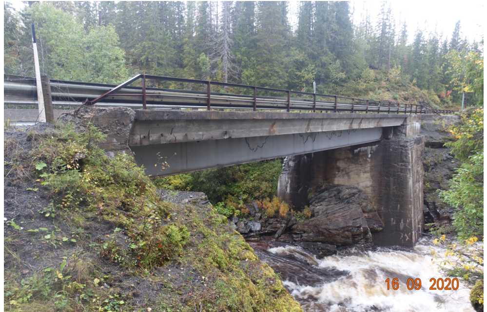
Figur 1 Bilde av dagens bru.
