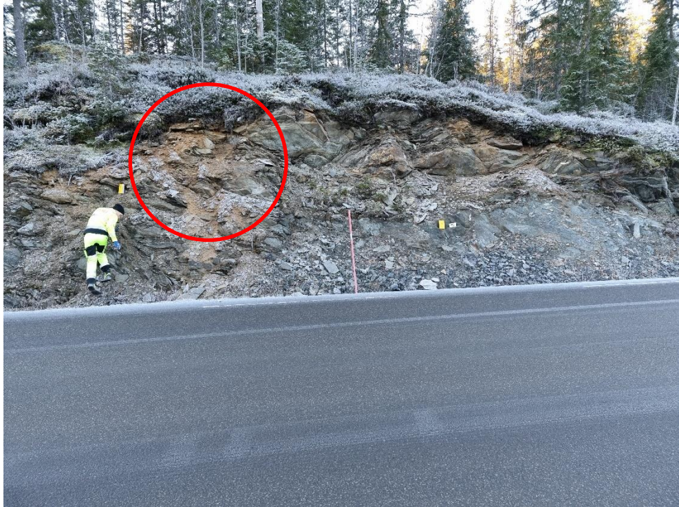
Figur 6.3-1: Oversiktsbilde fra befaringslokalitet B02. Bildet er tatt mot sør-vest med person for skala. Til dels svært forvitret og knust berg (rød ellipse).
