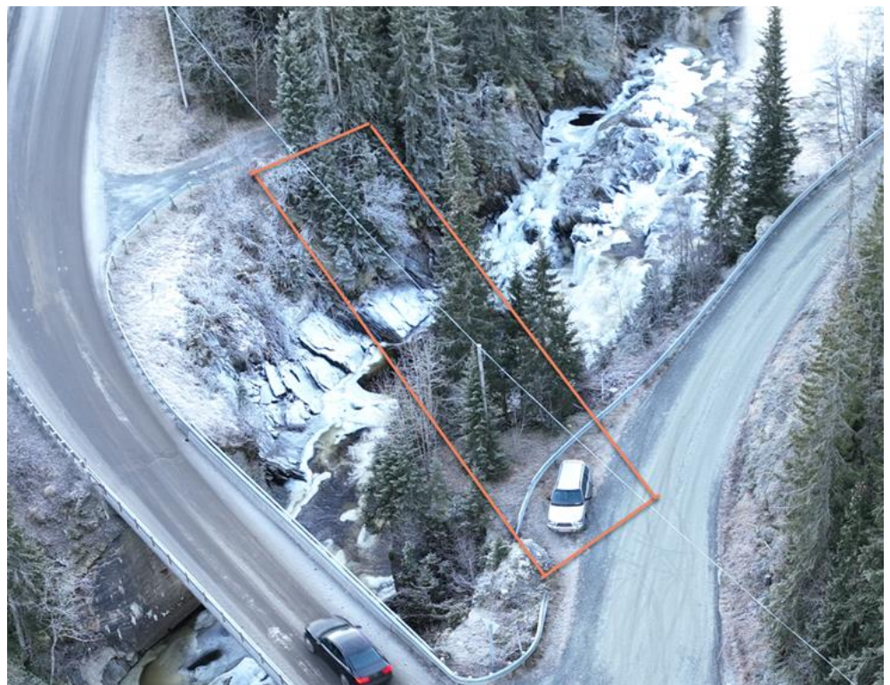
Figur 13.4-1: Avtrykk av ny bru i eksisterende terreng. På tidspunkt for denne rapporten arbeides det fremdeles med plassering av landkar, og følgelig plassering av byggegrop.
