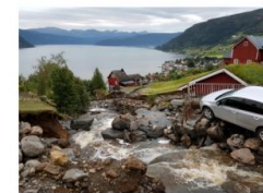
Store skader forårsaket av flom i Ulvik i 2017.
