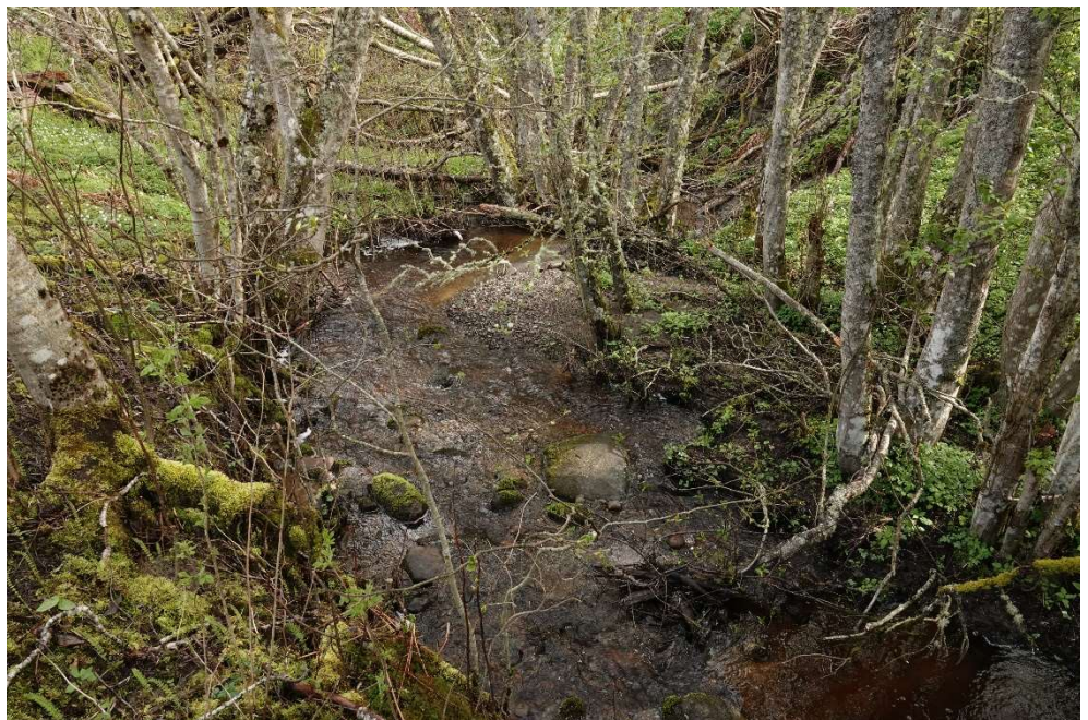
Figur 4-13 Situasjonsfoto oppstrøms kulvert
