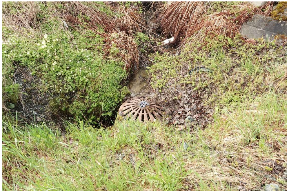
Figur 4-31 Kum inn til kulvert oppstrøms veien
