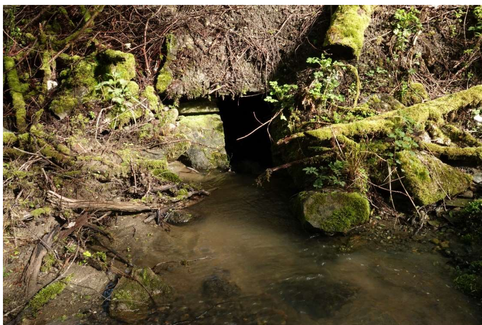
Figur 4-25 inngang til fylling under veien
