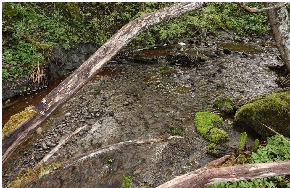
Figur 4-14 Situasjonfoto oppstrøms kulvert
