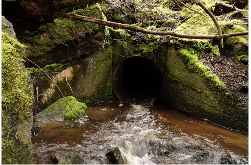
Figur 4-15 Situasjonsfoto utløp fra kulvert nedstrøms veien
