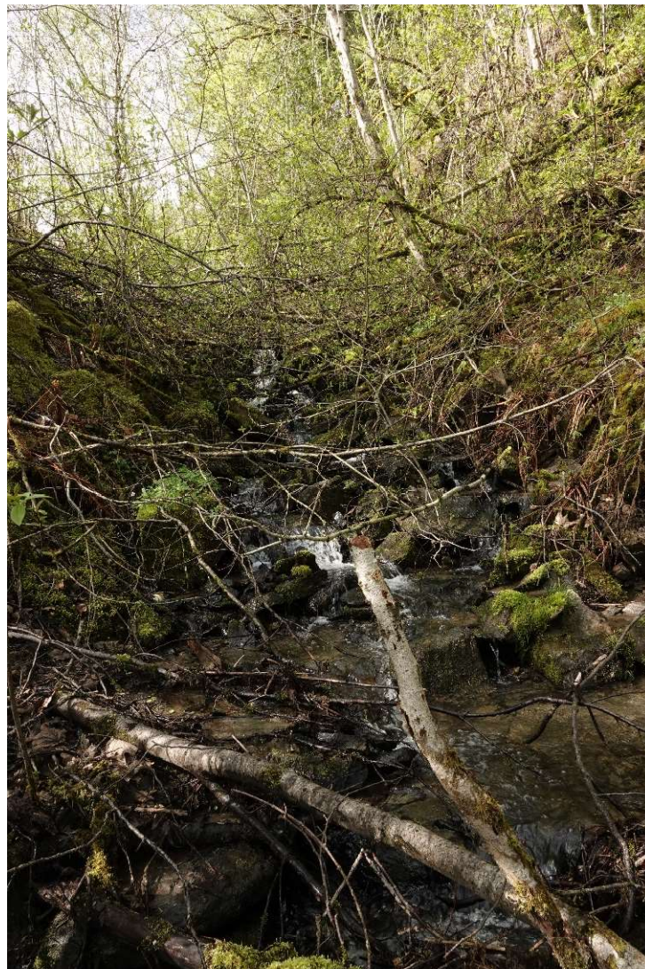
Figur 4-10 Situasjonsfoto utløp fra fyllingen nedstrøms veien
