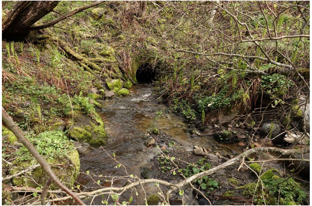
Figur 4-12 Situasjonsfoto innløp kulvert oppstrøms veien
