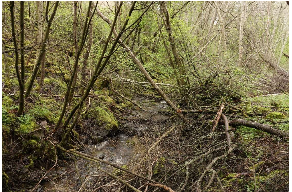
Figur 4-16 Situasjonsfoto nedstrøms kulvert
