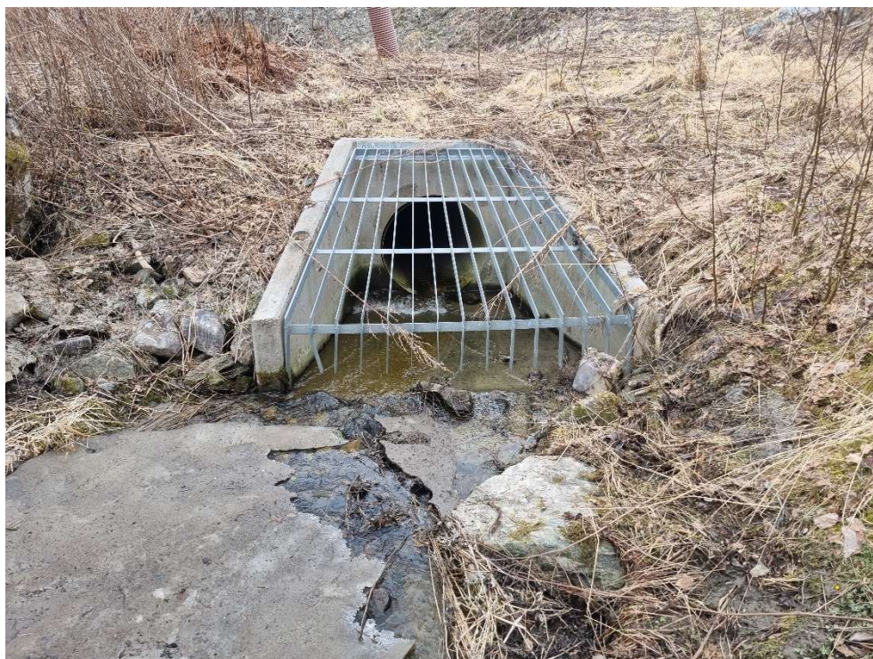
Figur 4-20 Kulvert inn i eksisterende fylling.
