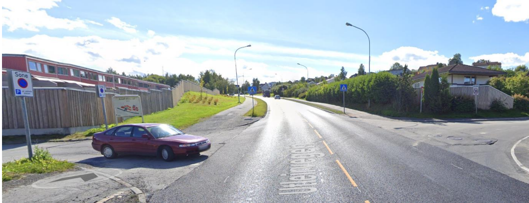
Figur 7: Ved Adolf Øiens veg til venstre i bildet er det etablert støyskjermer allerede.
