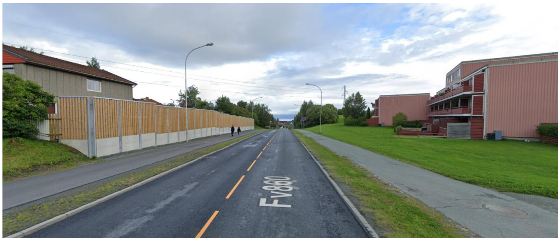
Figur 29 Eksisterende støyskjerm på motsatt side av vegen ved Utleirtunet 2-6. Det må sikres at betongmuren ikke medfører refleksjonsbidrag mot andre sida av vegen.
