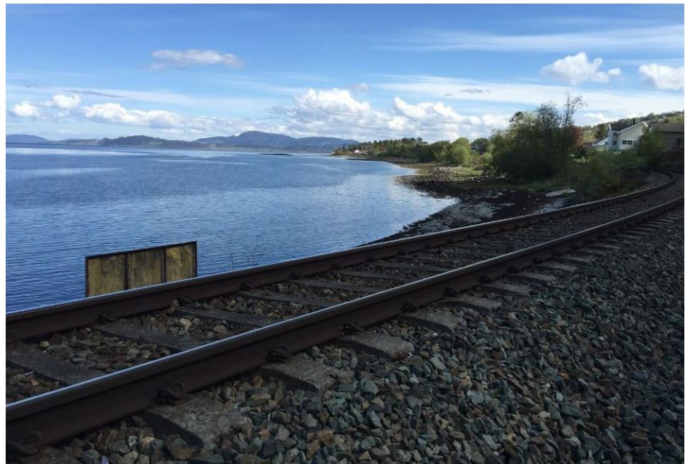
Figur 8-4. Strandsonen mellom tunnelpåhugget og Vikhammer stasjon. Foto: Torgeir Isdahl.
