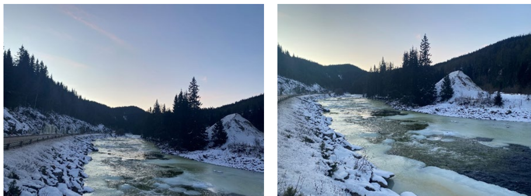
Figur 21: Viser Gaula og dagens veg. (Foto: Asgeir Gylland)
