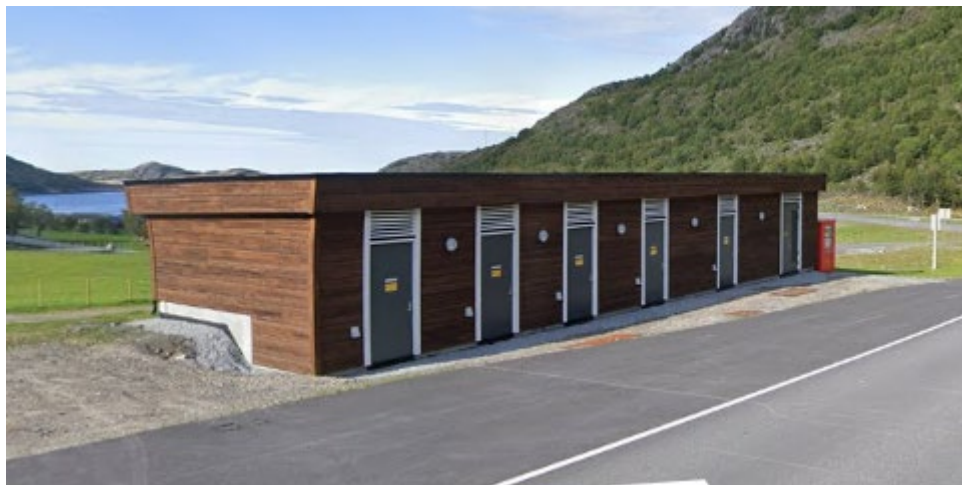
Figur 10: Eksempel på teknisk bygg (fv. 6312 i Roan, maps.google.com )
