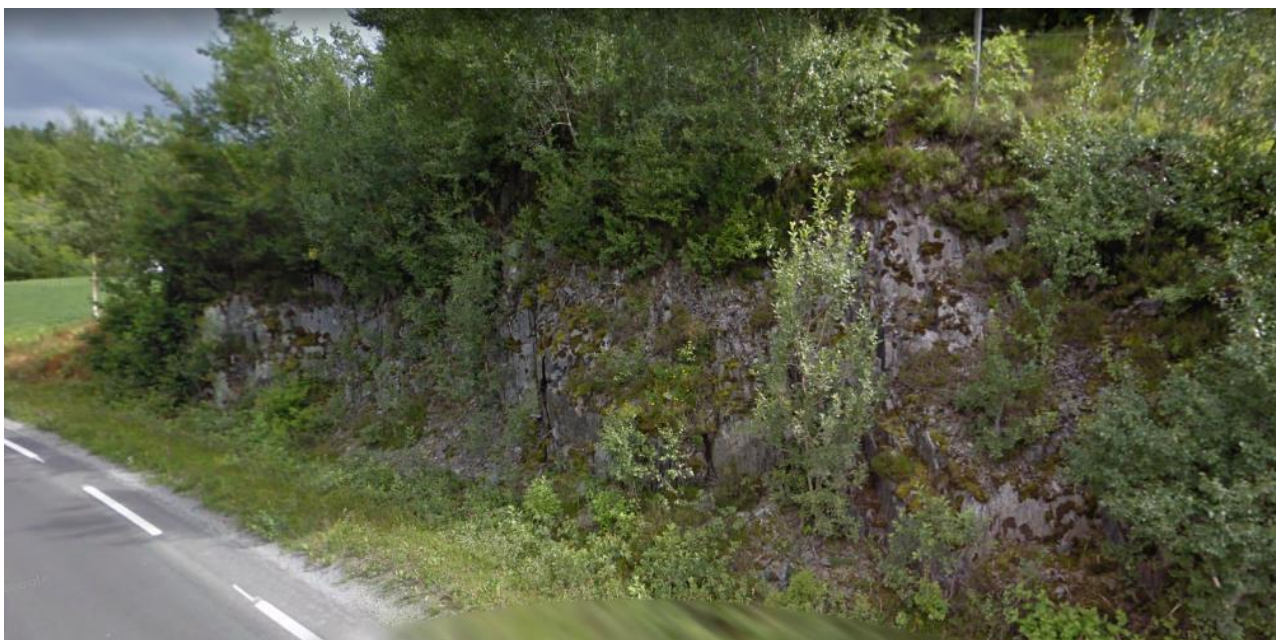
Figur 13. Skifrig bergmasse ved eksisterende bergskjæring ved Bradden. Bildet er hentet fra Google Streetview (Google, 2020).
