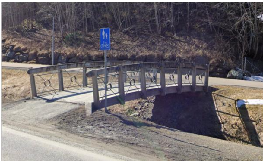
Figur 28: Eksisterende gang- og sykkelveg over Heimdalsbekken fra Google Street View.
